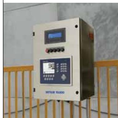
Упростить взвешивание движущегося состава можно с помощью контроллера, который считывает идентификационный номер вагона и показания весов. Контроллер способен хранить в памяти информацию о сотнях составов и выводить данные на печать.
