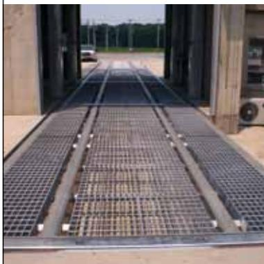
Наклонная платформа со стальным решетчатым настилом предназначена для разгрузки зерна с автомобиля, находящегося на весах. Такая конструкция позволяет одновременно проводить взвешивание и разгрузку на одной платформе. Настил также является частью системы локализации на случай разлива жидкостей.
