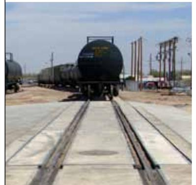
Faites des économies et gagnez de la place en utilisant un pont-basculé combiné pour camions et wagons. Un même pont-basculé associe un pont-basculé statique pour wagons et une plateforme de pesage de camions. Les rails sont encastrés de manière à former une surface plane sur laquelle les camions circulent facilement et en toute sécurité.
