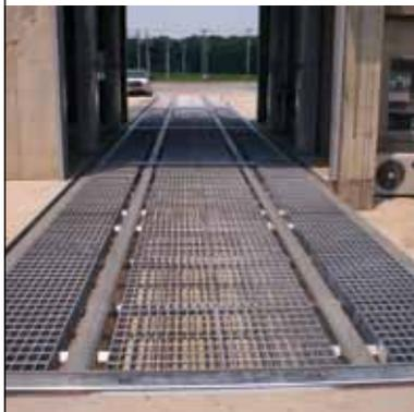
Incluyen una superficie de tránsito compuesta por una rejilla de acero sobre la que los camiones pueden descargar el grano mientras están sobre la báscula. Permite ahorrar tiempo al prescindir de los viajes entre la báscula y el área de descarga. La rejilla también se usa en sistemas de contención para evitar el derrame accidental de líquidos.
